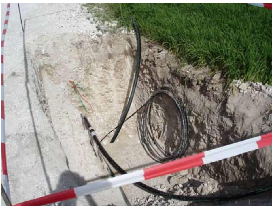
FIGURE 26 : PHOTO D'UNE TRANCHEE POUR L'ENFOUISSEMENT DES CABLES ELECTRIQUES
