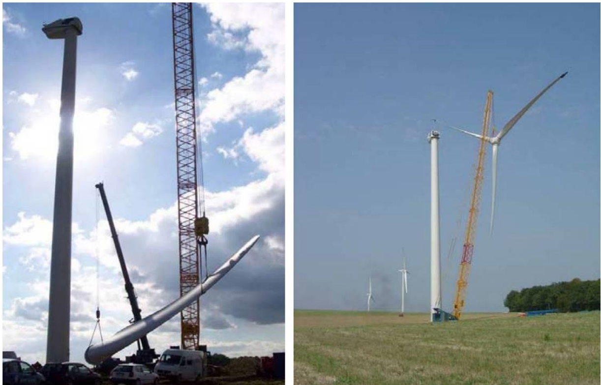
FIGURE 24 : GRUE DE MONTAGE ET ELEVAGE DU ROTOR
