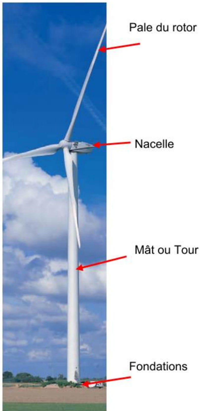
FIGURE 6 : DESCRIPTION D'UNE EOLIENNE
